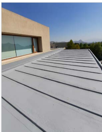
DESPUÉS DE LA IMPERMEABILIZACIÓN
