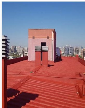
DESPUÉS DE LA IMPERMEABILIZACIÓN
