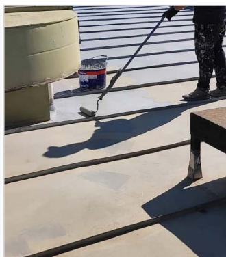
DURANTE LA IMPERMEABILIZACIÓN
