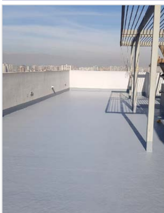
DESPUÉS DE LA IMPERMEABILIZACIÓN
