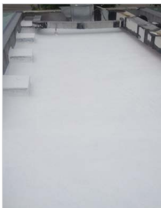
DESPUÉS DE LA IMPERMEABILIZACIÓN
