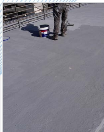
DURANTE LA IMPERMEABILIZACIÓN
