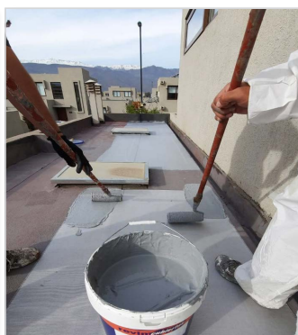
DURANTE LA IMPERMEABILIZACIÓN
