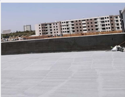
DURANTE LA IMPERMEABILIZACIÓN
