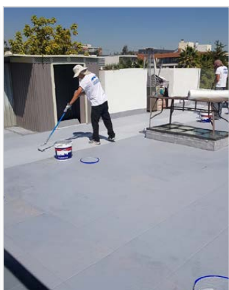
DURANTE LA IMPERMEABILIZACIÓN
