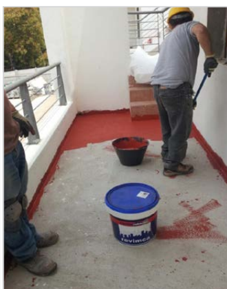
DURANTE LA IMPERMEABILIZACIÓN
