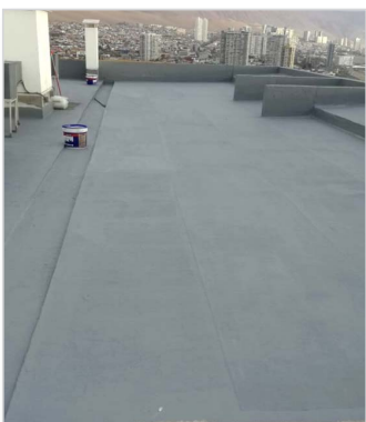
DURANTE LA IMPERMEABILIZACIÓN
