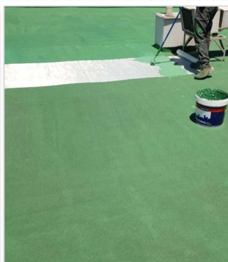
DURANTE LA IMPERMEABILIZACIÓN
