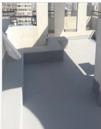
DESPUÉS DE LA IMPERMEABILIZACIÓN
