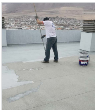
DURANTE LA IMPERMEABILIZACIÓN
