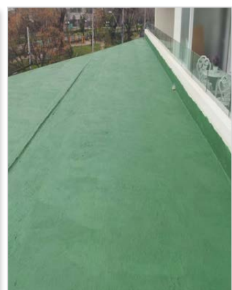
DESPUÉS DE LA IMPERMEABILIZACIÓN
