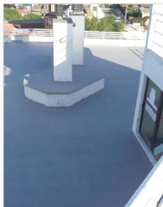
DESPUÉS DE LA IMPERMEABILIZACIÓN
