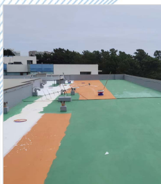
DURANTE LA IMPERMEABILIZACIÓN
