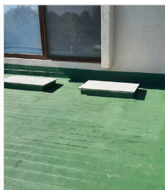
DURANTE LA IMPERMEABILIZACIÓN
