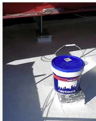
DURANTE LA IMPERMEABILIZACIÓN
