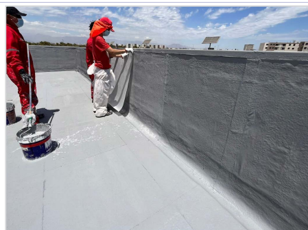
DURANTE LA IMPERMEABILIZACIÓN
