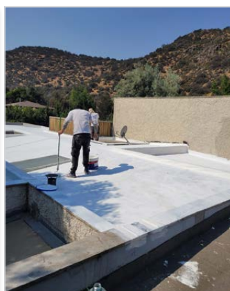
DURANTE LA IMPERMEABILIZACIÓN
