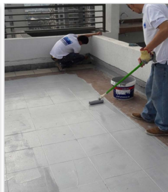
DURANTE LA IMPERMEABILIZACIÓN
