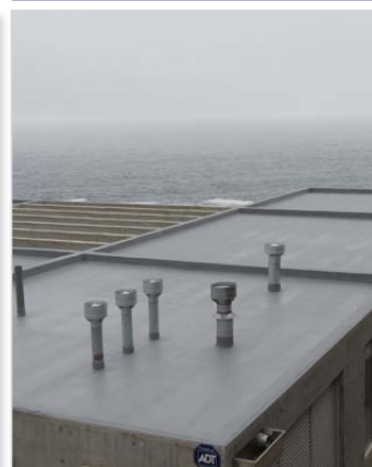
DESPUÉS DE LA IMPERMEABILIZACIÓN
