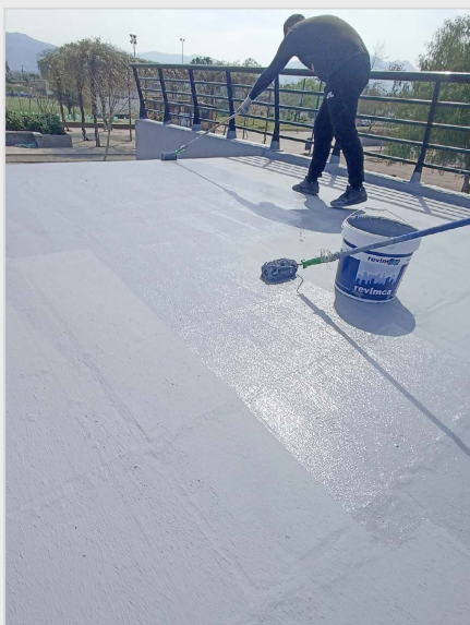
DURANTE LA IMPERMEABILIZACIÓN
