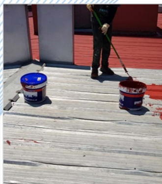
DURANTE LA IMPERMEABILIZACIÓN
