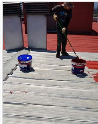
DURANTE LA IMPERMEABILIZACIÓN
