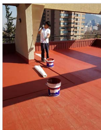
DURANTE LA IMPERMEABILIZACIÓN
