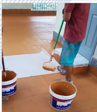
DURANTE LA IMPERMEABILIZACIÓN
