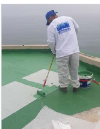
DURANTE LA IMPERMEABILIZACIÓN
