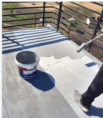
DURANTE LA IMPERMEABILIZACIÓN
