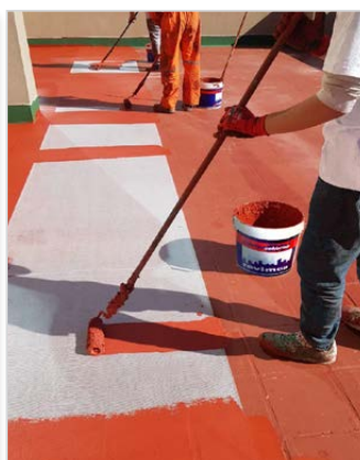
DURANTE LA IMPERMEABILIZACIÓN
