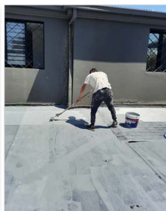
DURANTE LA IMPERMEABILIZACIÓN
