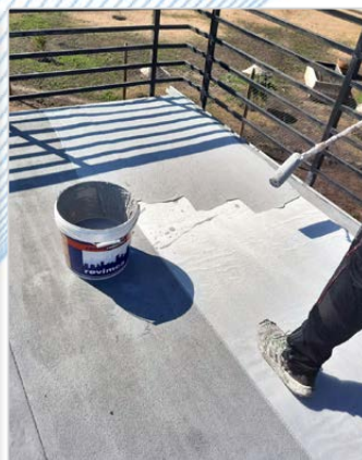
DURANTE LA IMPERMEABILIZACIÓN
