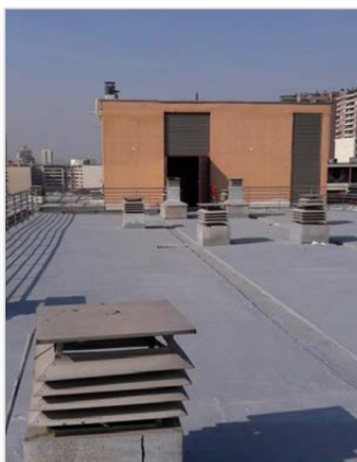
DESPUÉS DE LA IMPERMEABILIZACIÓN
