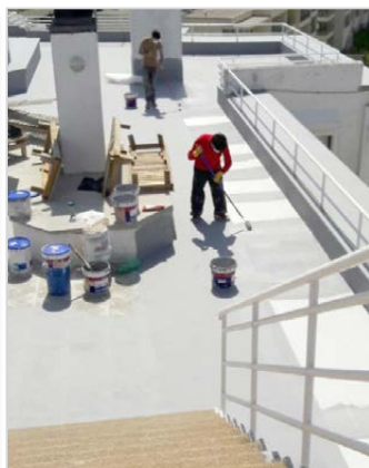
DURANTE LA IMPERMEABILIZACIÓN
