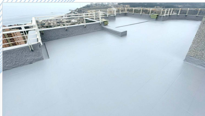
DURANTE LA IMPERMEABILIZACIÓN
