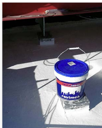
DURANTE LA IMPERMEABILIZACIÓN
