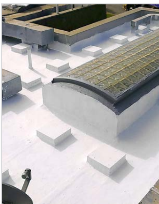
DESPUÉS DE LA IMPERMEABILIZACIÓN
