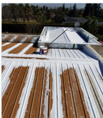
DURANTE LA IMPERMEABILIZACIÓN
