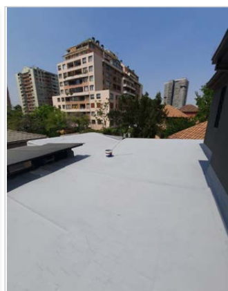
DESPUÉS DE LA IMPERMEABILIZACIÓN
