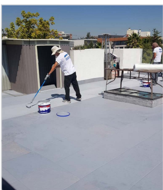
DURANTE LA IMPERMEABILIZACIÓN
