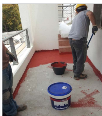
DURANTE LA IMPERMEABILIZACIÓN
