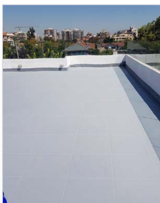
DESPUÉS DE LA IMPERMEABILIZACIÓN
