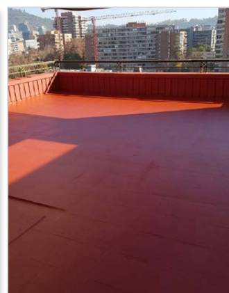
DESPUÉS DE LA IMPERMEABILIZACIÓN
