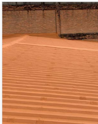
DURANTE LA IMPERMEABILIZACIÓN
