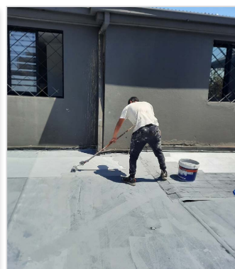
DURANTE LA IMPERMEABILIZACIÓN
