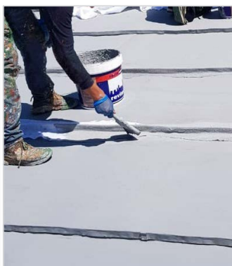
DURANTE LA IMPERMEABILIZACIÓN
