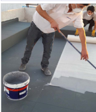
DURANTE LA IMPERMEABILIZACIÓN
