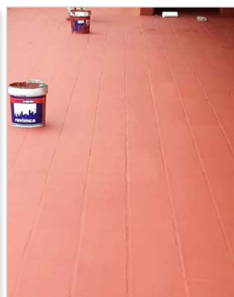
DESPUÉS DE LA IMPERMEABILIZACIÓN
