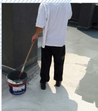
DURANTE LA IMPERMEABILIZACIÓN
