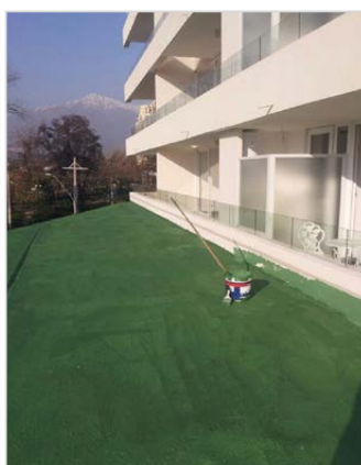
DURANTE LA IMPERMEABILIZACIÓN
