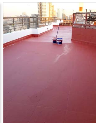
DESPUÉS DE LA IMPERMEABILIZACIÓN
