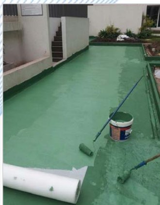
DURANTE LA IMPERMEABILIZACIÓN
