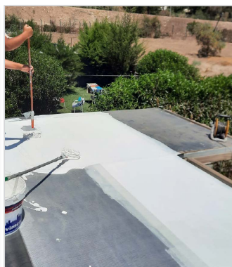
DURANTE LA IMPERMEABILIZACIÓN
