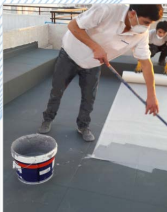
DURANTE LA IMPERMEABILIZACIÓN
