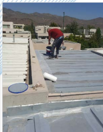
DURANTE LA IMPERMEABILIZACIÓN
