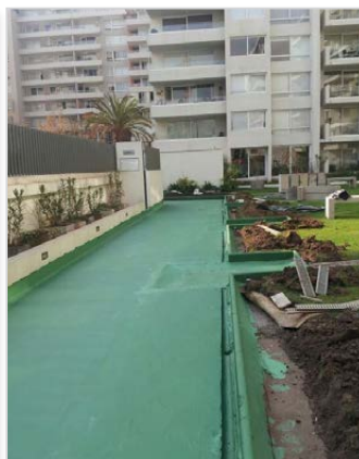
DESPUÉS DE LA IMPERMEABILIZACIÓN
