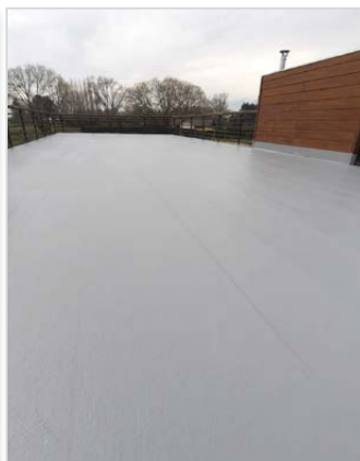
DESPUÉS DE LA IMPERMEABILIZACIÓN
