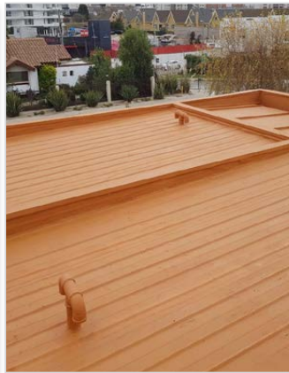
DESPUÉS DE LA IMPERMEABILIZACIÓN
