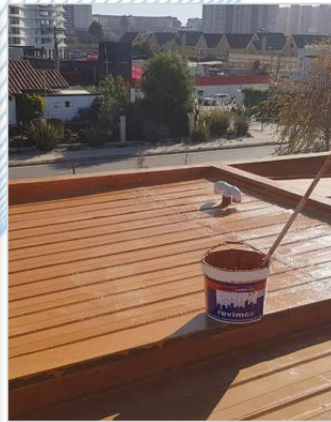
DURANTE LA IMPERMEABILIZACIÓN
