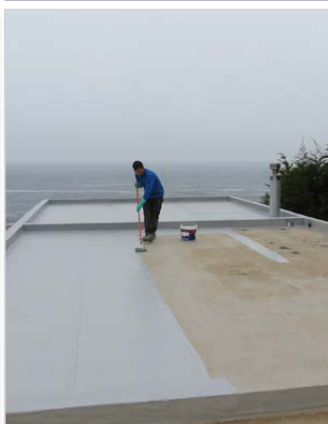
DURANTE LA IMPERMEABILIZACIÓN
